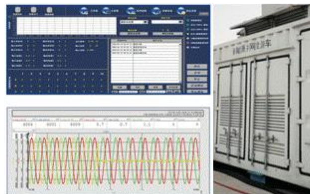
6/10kV/6MVA 储能测试平台
